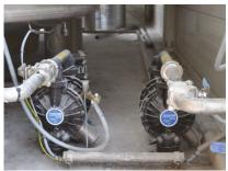
Herr Nicolai, Leiter der Wartungsabteilung von Koopman, hatte festgestellt, dass die in der Anlage verwendete Druckluftmembranpumpe schwierig in Topzustand zu halten war und darüber hinaus die Maschine ziemlich teuer war. Verder installierte mehrere Verderair-Membranpumpen. Prüfgänge zeigten, dass diese Pumpen durch das Luftventil an der Oberseite der Pumpe und folglich den schnellen Zugriff auf die Membranen viel einfacher zu warten sind.
