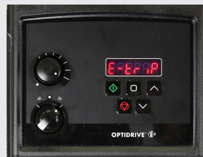
Display zeigt ausgelöste Schlauchbruchüberwachung an
