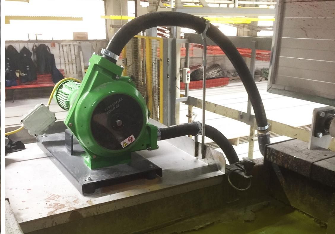
Die Schlauchpumpe Verderflex Rollit ist ein sogenannter „Trockenläufer“ und optimal für das Fördern und Dosieren von abrasiven, korrosiven oder auch scherempfindlichen Flüssigkeiten geeignet.
