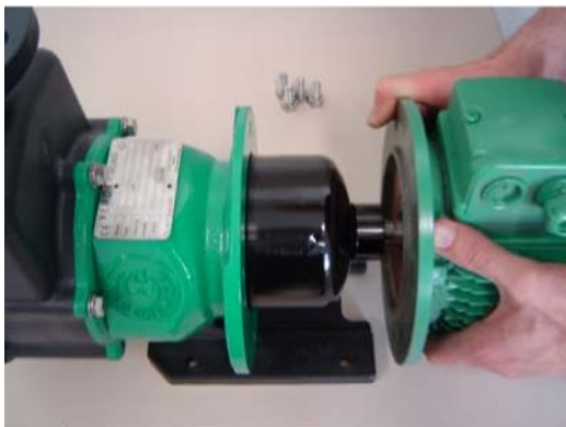
Abbildung 22: Pumpe und Motor montieren
